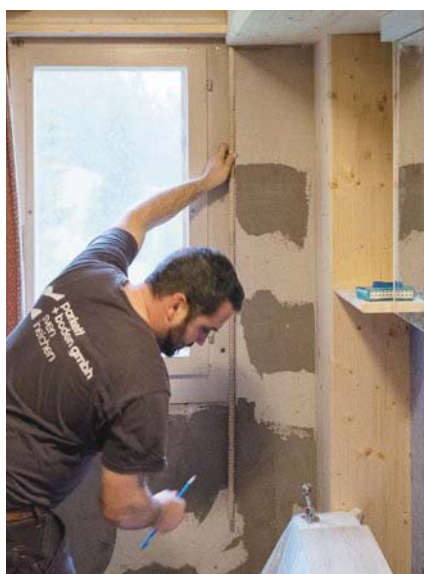
Im Bade- und Wohnzimmer wurden die Wände und Böden mit Eco Prim T grundiert.
