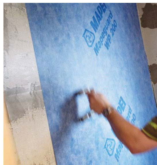
Die Wände wurden mit Mapeguard WP 200 und die Innenecken mit Mapeguard IC abgedichtet.
